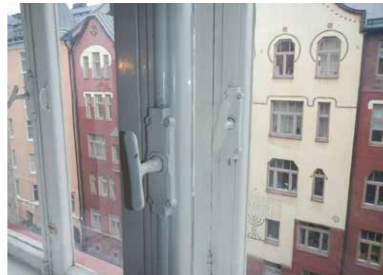
Schalinin talossa ulko- ja sisäpuitteilla on erilliset karmit, jolloin väliin jäävä ilmarako on tavallista suurempi. Osassa ikkunoita on pitkäsulkija. (Kuva: Vahanen Oy)
