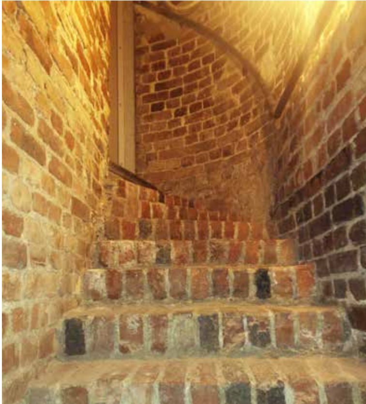
Kellarissa on hyvin nähtävissä tiilimuurausta. E-portaan kellariporaat on myös tiiltä. Oikealla seinustalla on nähtävissä säännölliset pää- ja juoksukerrokset. (Kuva: RL)
