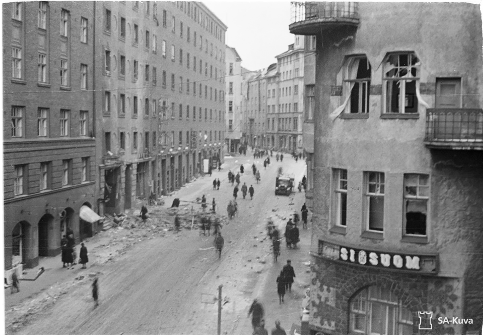
Jatkosodan aikana 1944 vastapäätä Kapteeninkatua osunut pommi tuhosi Schalinin talossa kaikkien Kapteeninkadun puoleisten ikkunoiden lasit sekä C-portaan oven. Muut ulko-ovet ja ikkunoiden karmit ovat alkuperäisiä, samoin kuin myös ulkoseinien rappaus. (Kuva: SA-kuva)
