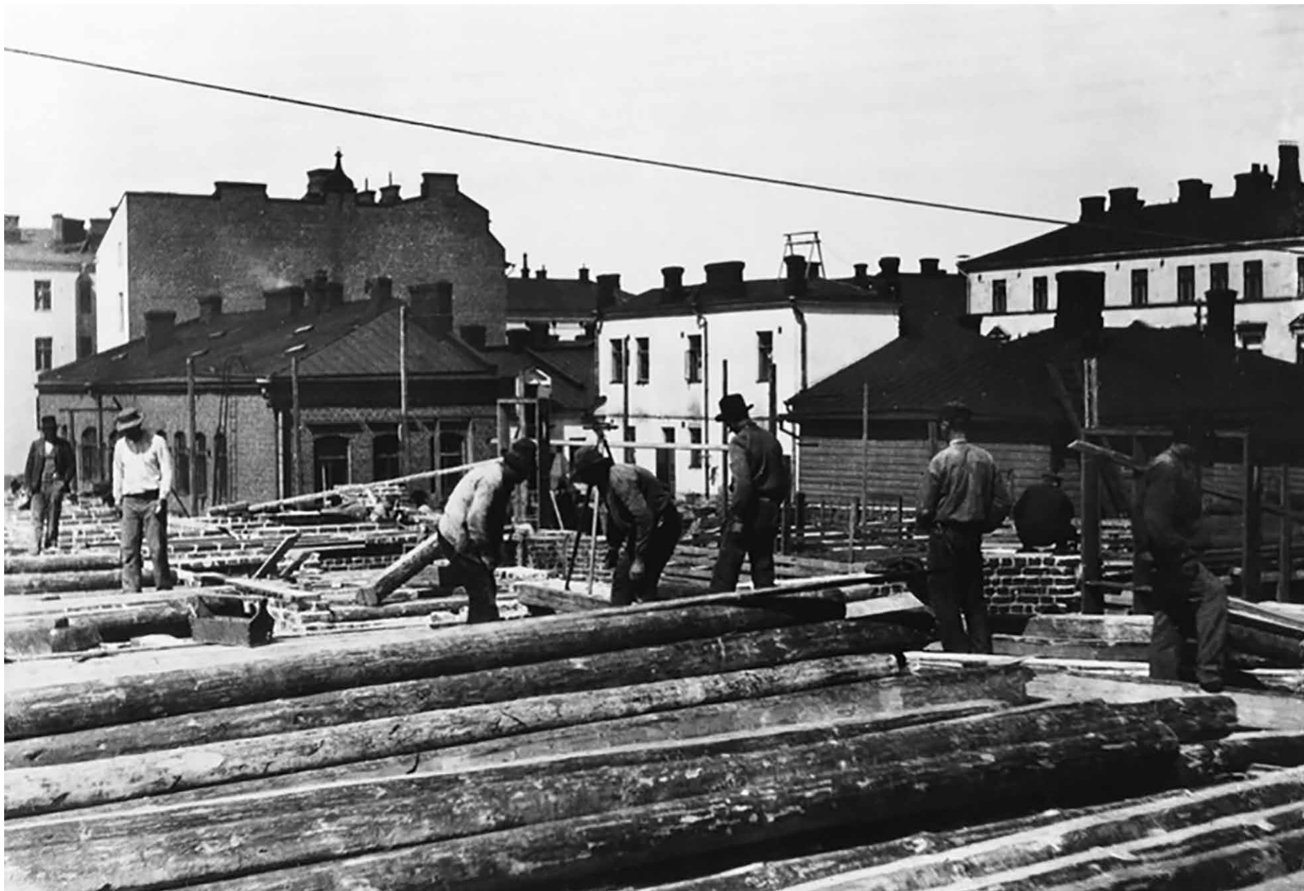
Puisia välipohjavesoja työmaalla. (Kuva: Andersin, Ernst. 1904. Helsingin kaupunginmuseo.)
